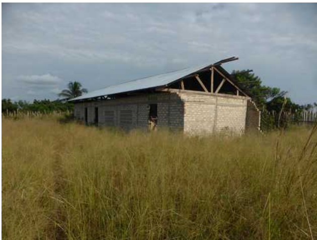
L'école en construction
